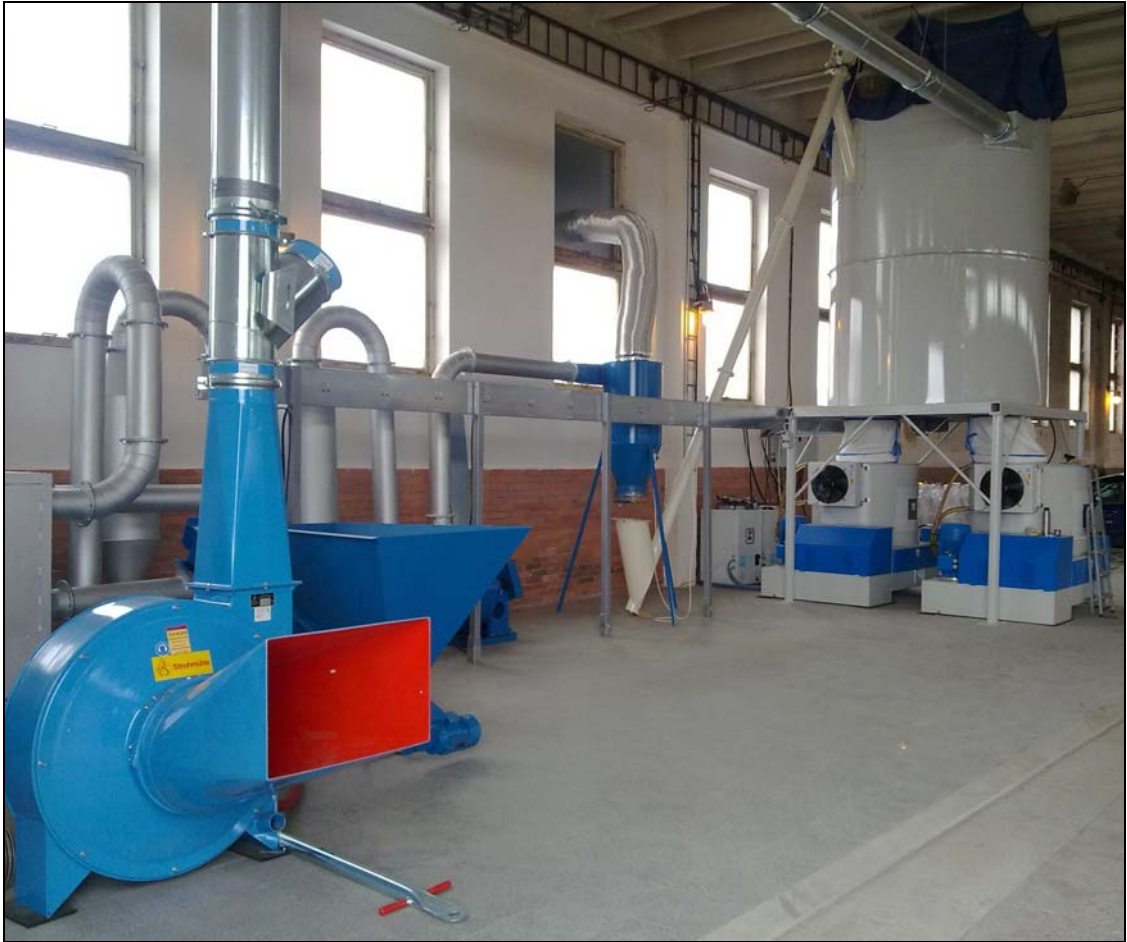
Instalace s drtičem HIMEL STM 201, sušárnou pilin a štěpky, silem na surovinu a dvojicí lisů CO.MA.FER. DINAMIC
